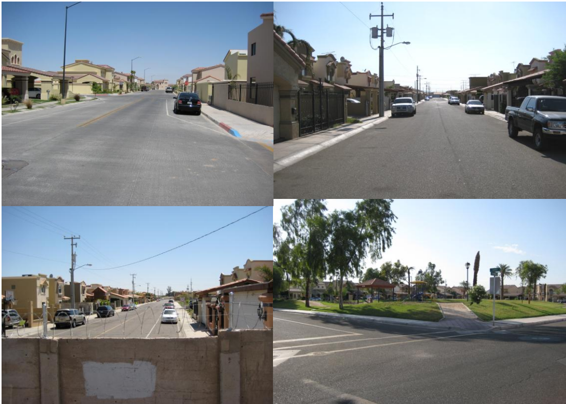
Imagen 23. Vistas al interior de diversos fraccionamientos cerrados, donde se aprecia la falta de circulación peatonal.
