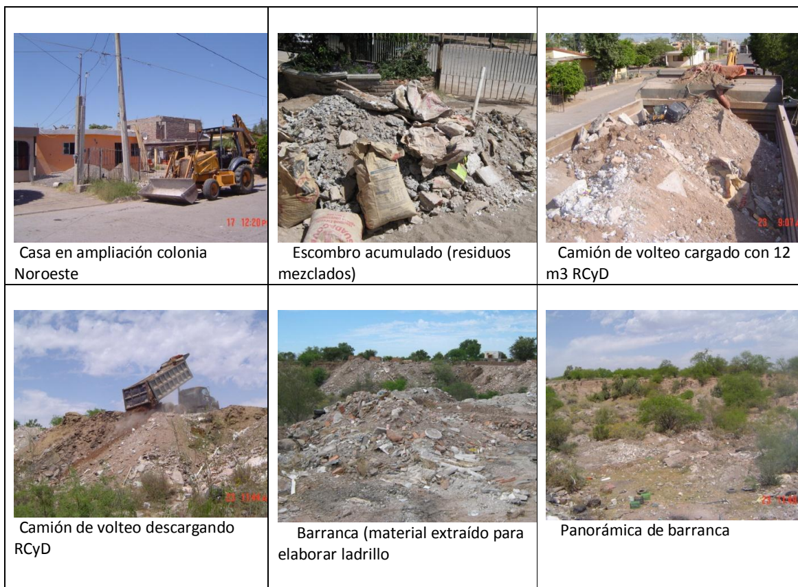
Figura 28. Residuos de remodelación y demolición, (casa en colonia Noroeste, Cd. Obregón, Sonora) y su disposición final
