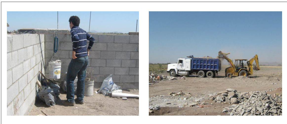
Figura 31. Pesaje de residuos de poco volumen y carga de residuos voluminosos en camión de volteo.
