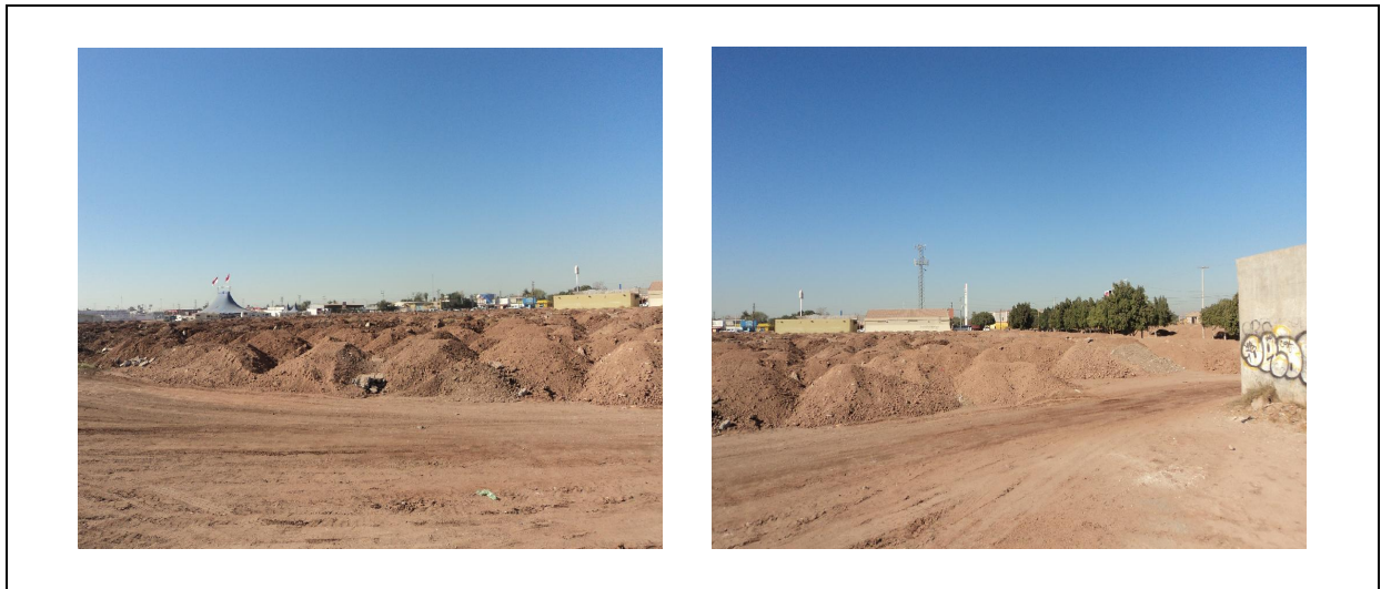
Figura 4. Acumulación de material de relleno en su condición natural
