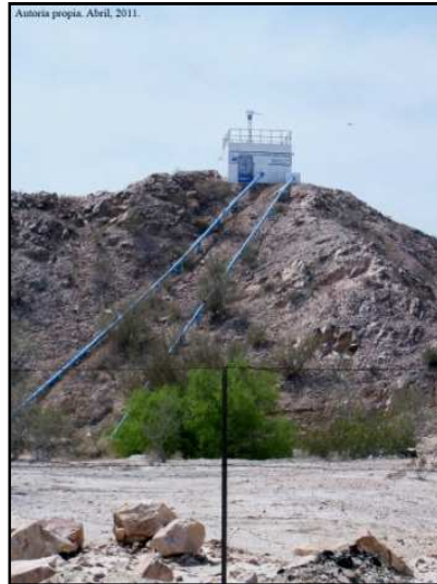
Foto 20. Abastecimiento de agua potable
