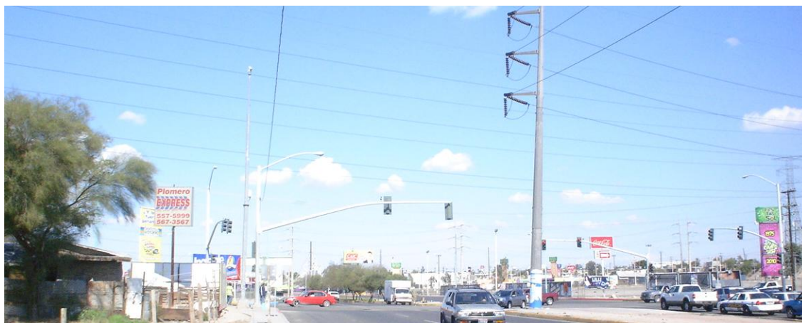
Figura 30. Cruce Independencia y los Presidentes, dominio en plano vertical de torres de energía eléctrica, cables, semáforos y anuncios publicitarios en ambos sentidos. Camellón principal sin cobertura vegetal (der.).
