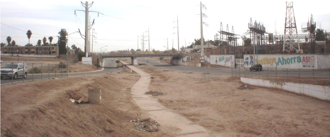
Figura 21. Camellón principal sin vegetación. Condominios Monte Albán en proceso de demolición (izq.) y subestación de energía eléctrica (der.)
