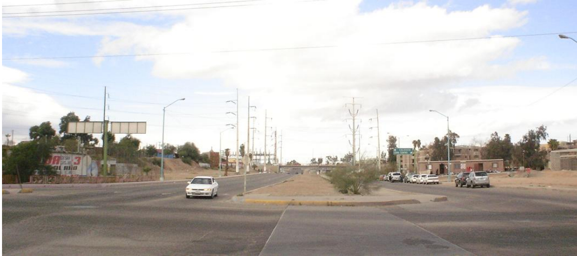
Figura 22. Nueva comandancia (der.). Camellón principal sin vegetación y laderas del río. Presencia en plano vertical de torres de energía eléctrica y alumbrado público.
