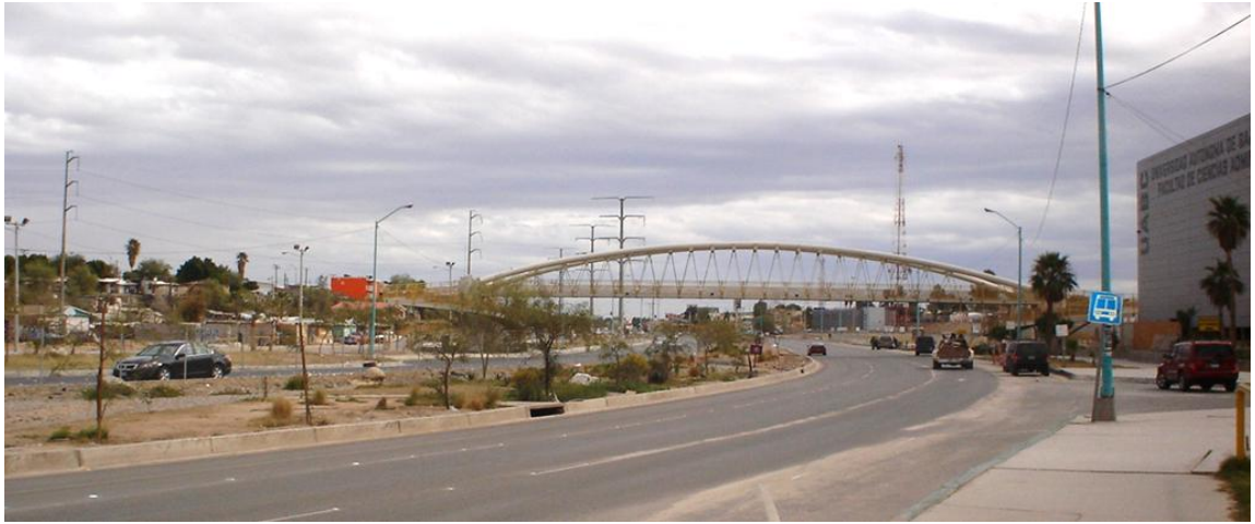
Figura 37. FCA y puente peatonal. Camellón principal con vegetación (izq.) en mal estado sólo frente a la Facultad de Ciencias Administrativas (FCA), paisaje enmarcado por el puente peatonal de forma curva (centro) en contraste con la forma rectangular de la FCA (der.).
