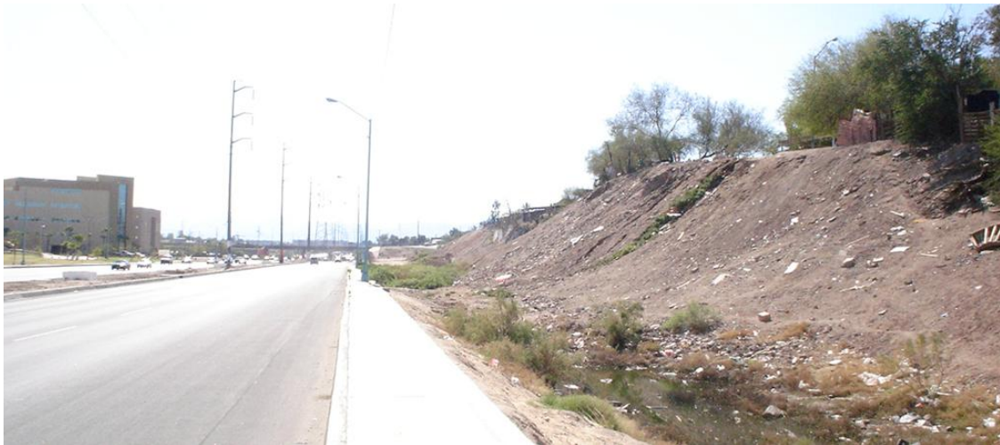
Figura 32. Ladera del río (der.) con cobertura vegetal sólo en la base y en la parte superior y faltante en laderas. El edificio de Justicia, de la Procuraduría del Estado (izq.), con vegetación frente a ellos y el camellón (izq.) sin cobertura vegetal. Las torres de energía eléctrica marcan el plano vertical junto con las luces mercuriales.
