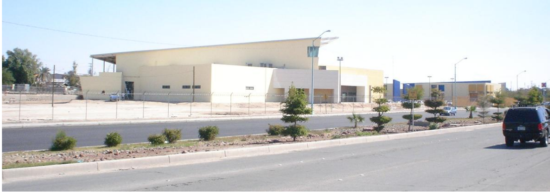
Figura 26. Estacionamiento de equipo pesado y Centro de convenciones. Camellón principal con vegetación y patio de maniobras del Centro de Convenciones (izq.) sin cobertura.
