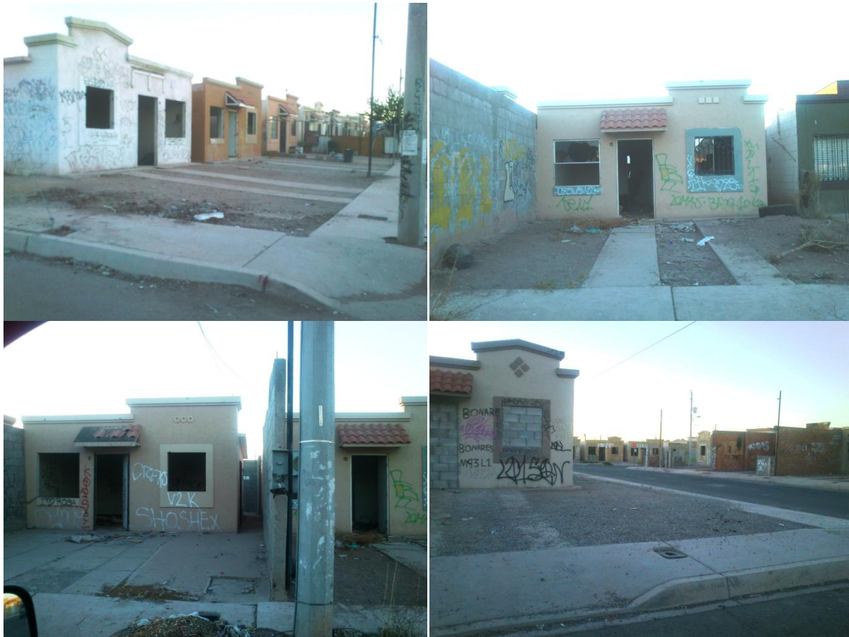
Imagen 4.12 Viviendas vandalizadas con presencia de grafiti.
