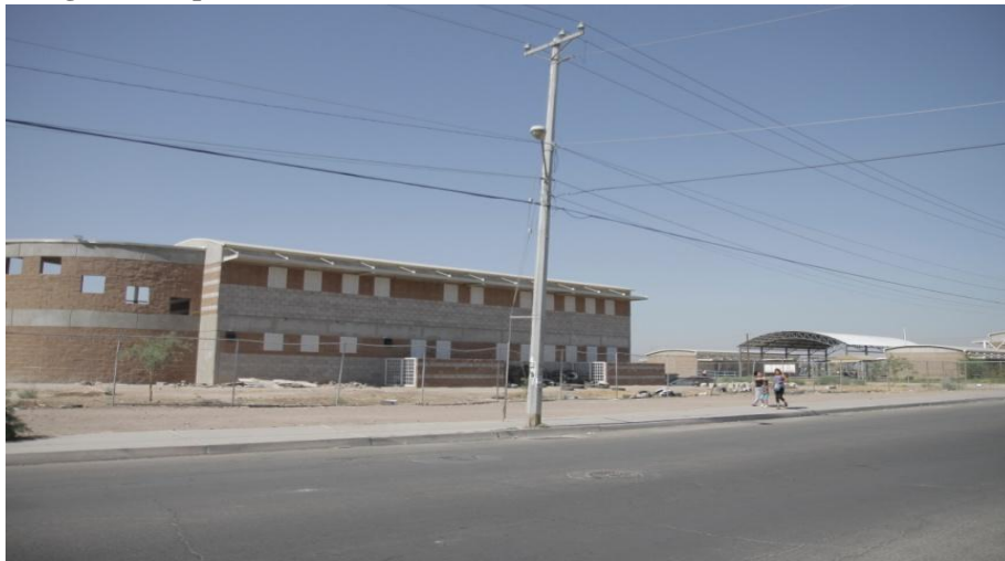
Imagen 4.5 Aspecto de la zona escolar del Fraccionamiento Villa Lomas Altas.
