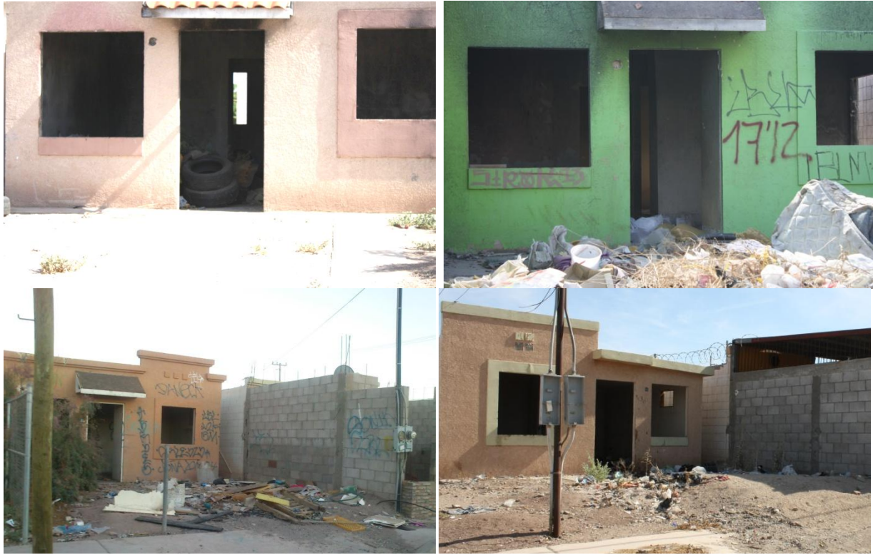
Imagen 4.15 vista de viviendas deshabitada con presencia de basura.
