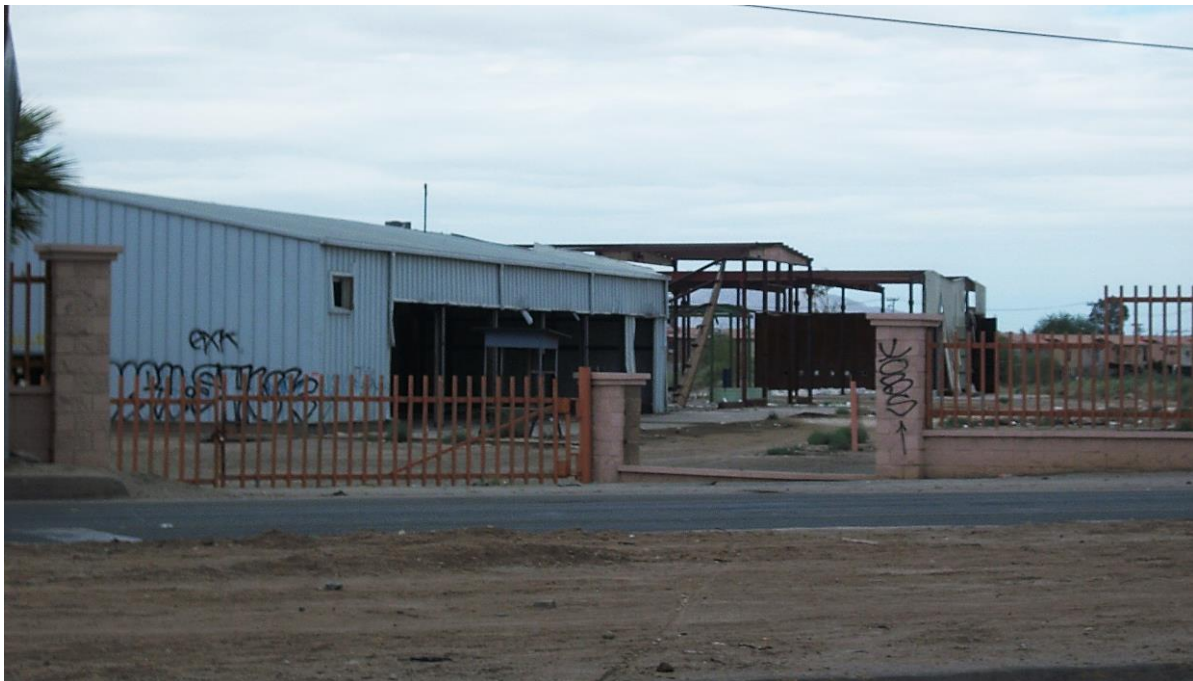
Figura 57. Instalaciones en desuso en kilómetro 1.5 de la Carretera Mexicali-San Felipe Fuente: Fotografía propia tomada el 2 de junio de 2015.
