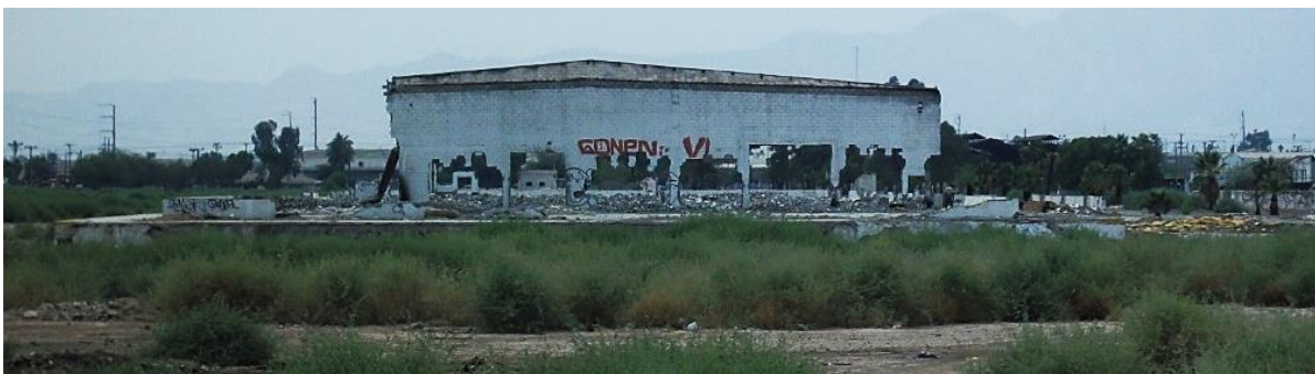
Figura 33. Vestigios de las antiguas instalaciones de QUOMSA
