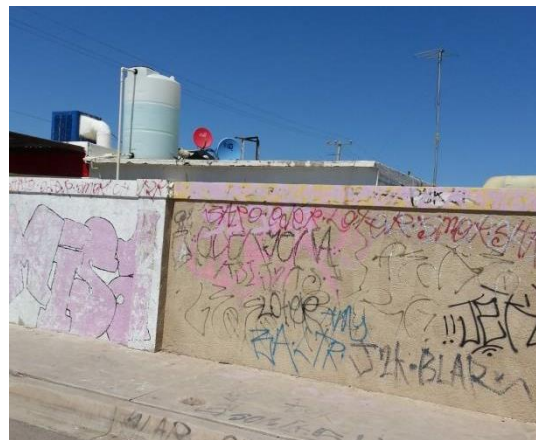
Figura 21. Presencia de vandalismo en el área.
