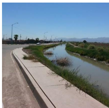
Figura 13. Dren que corre lateral a la vialidad de acceso al fraccionamiento.
