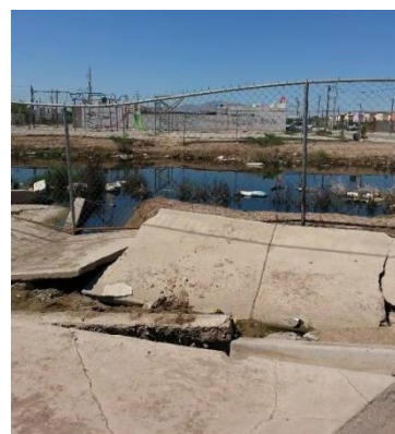
Figura 15. Esta es un área cercada dentro del fraccionamiento, apreciándose el mal estado de las banquetas, basura y el encharcamiento provocado por las fuertes lluvias.
