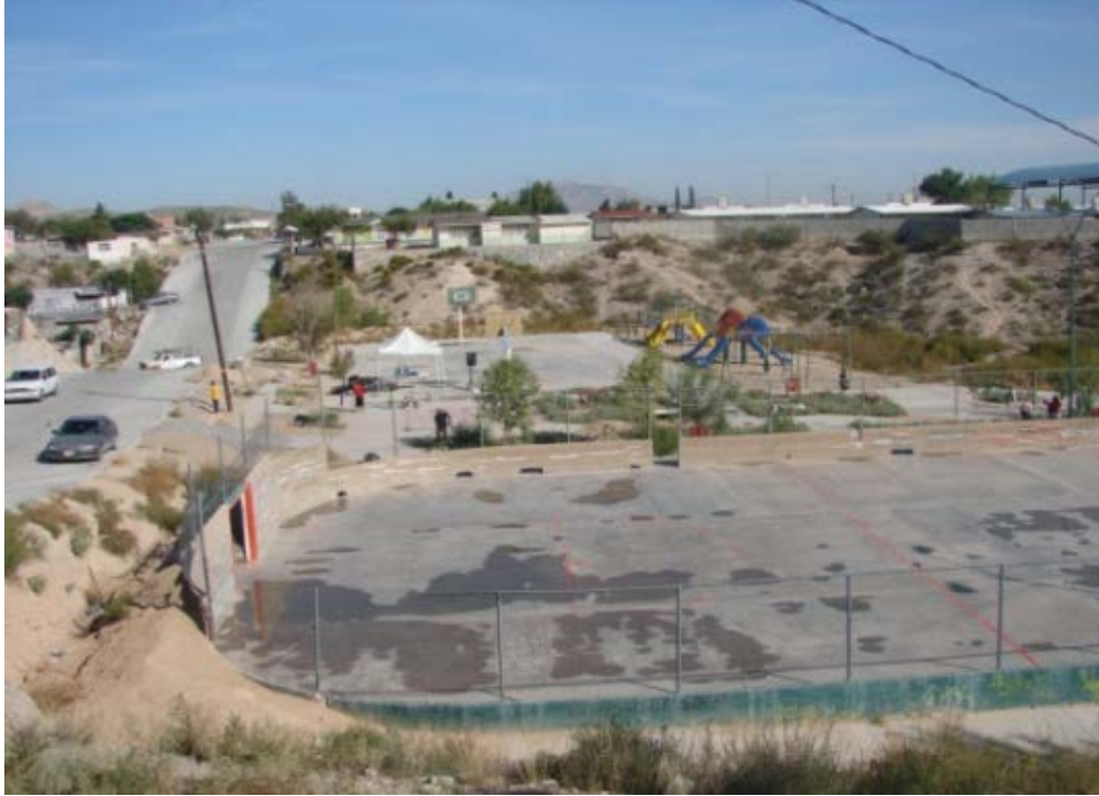
Ilustración 3: Parque Granito previo a su intervención Foto: IMIP, 2010
