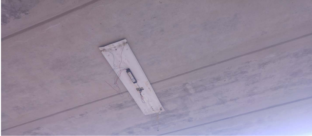
Ilustración 15: Lámparas vandalizadas, parque Clouthier
