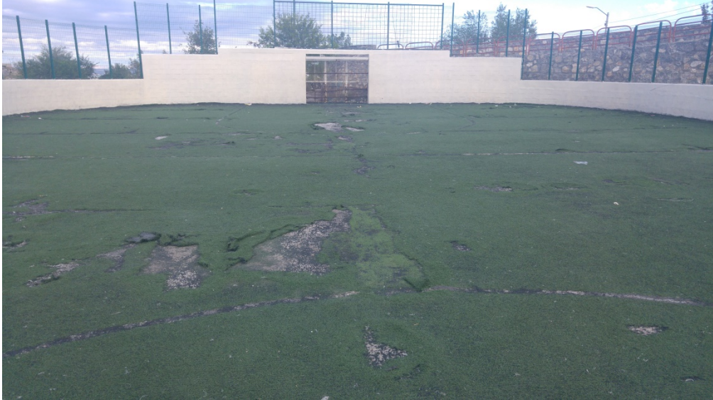
Ilustración 13: Deterioro pasto sintético cancha de fútbol
