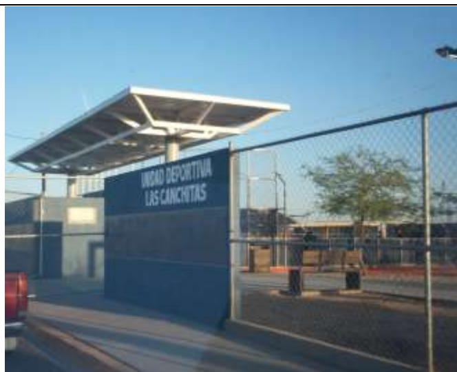
Fotografía 9 puertas de acceso y banqueta en buen estado, Abril de 2014
