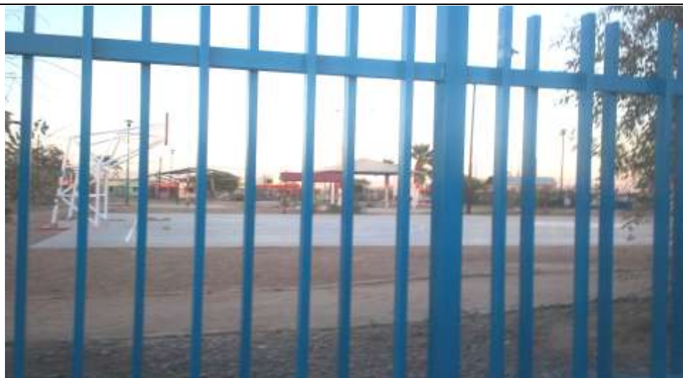
Fotografía 42 cerco tubular, noviembre 2013
