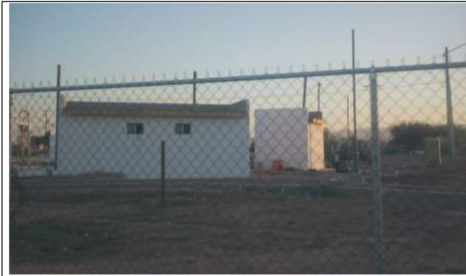
Fotografía 10 módulos sanitarios en buen estado, Noviembre 2013
