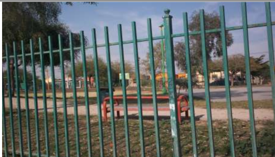
Fotografía 133 cerco tubular, enero de 2014
