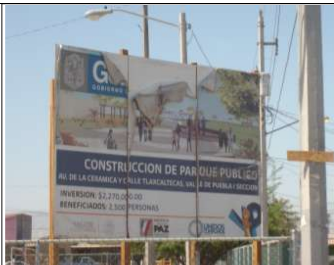
Fotografía 18 letrero sobre la reconstrucción del parque, se observa inversión y número de beneficiados
