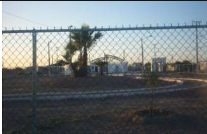
Fotografía 8 cerco de malla ciclónica, pista para caminar en buen estado, Noviembre 2013
