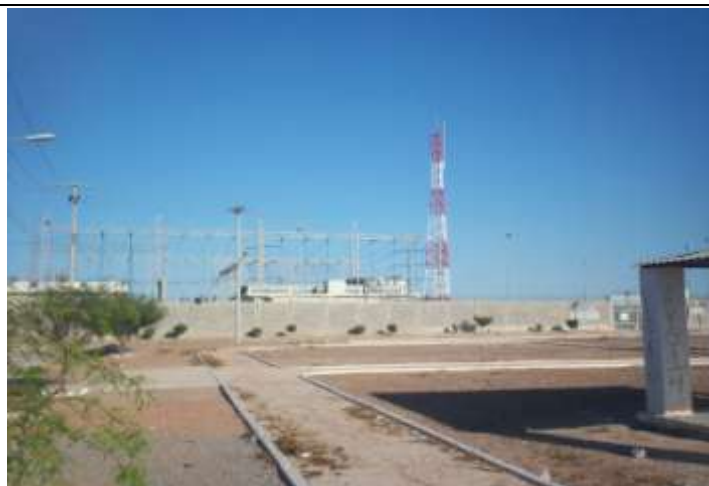
Fotografía 161 banquetas, abril de 2014
