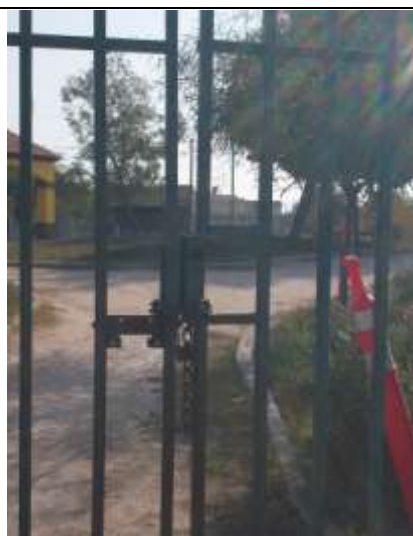
Fotografía 135 puerta de acceso cerrada, Enero de 2014
