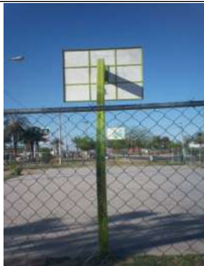
Fotografía 95 cerco de malla ciclónica, abril 2014
