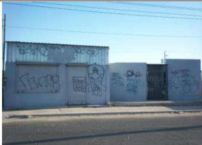
Fotografía 67 grafiti en casas abandonadas y deshabitadas frente al parque, abril 2014
