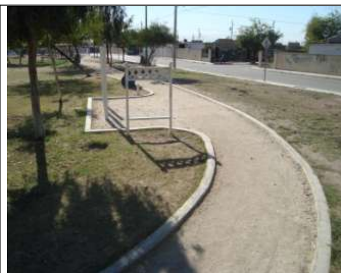
Fotografía 92 pista para caminar (andador), enero 2014
