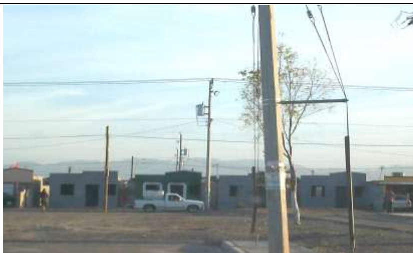
Fotografía 35 casas abandonadas frente al parque, abril 2014
