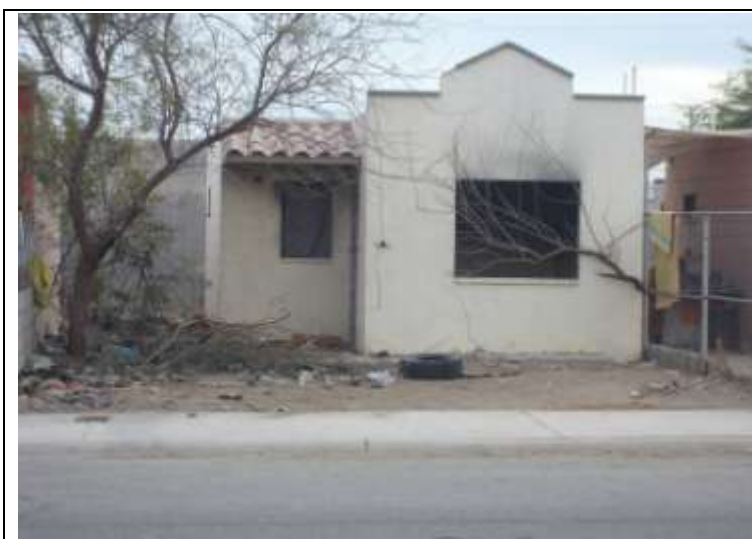
Fotografía 17 basura, llantas en casa abandonada y deshabitada, Febrero 2014
