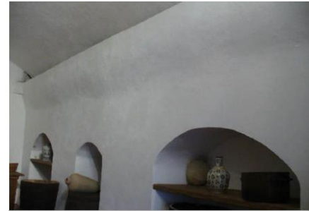
Fig.1 Ex Colegio Jesuita Tepetzotlán. Muro del frigorífico, adosado al muro concirculación de agua.
