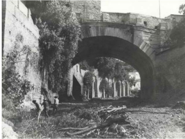
Foto 1.- Río Guanajuato azolvado, abajo del puente de Tepetapa. Fuente: archivo histórico
