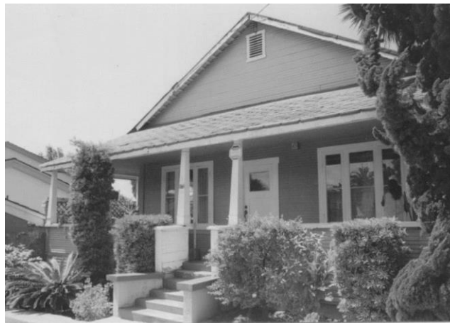
Figura 4. Obsérvese el respiradero, pórtico, ático ventilado, vegetación. Fuente: C. Calderón 2016
