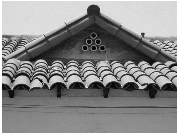
Figura 6. Detalle de ático ventilado. Fuente: C. Calderón 2016
