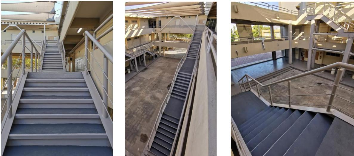
Un avance significativo es el que se aprecia con los trabajos de mantenimiento de los dos módulos de escaleras del edificio central. Para ello, se hicieron trabajos de retiro de losetas, tratamiento detallado de estructura metálica, reposición de huellas de concreto, así como
